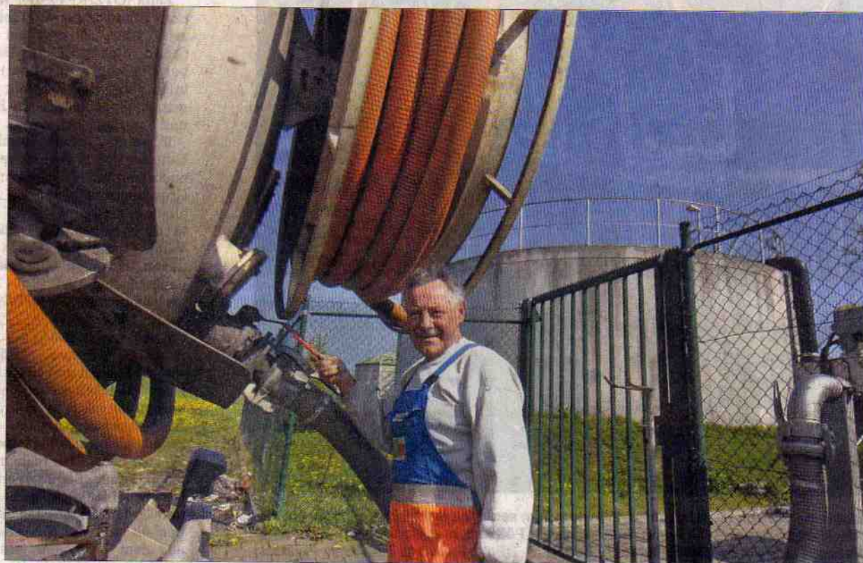
Wolfgang Müller von der Entsorgungsfirma Sita aus Neunhofen entleerte gestern bei jeder Fahrt elf Kubikmeter Fäkal-schlamm aus Kleinkläranlagen in der Abgabestelle der Kläranlage des Zweckverbandes Wasser-Abwasser in Pöbneck. In den nächsten Jahren sollen mehr Haushalte an zentrale Kläranlagen angeschlossen werden. (Foto: OTZ/Peter Cissek)
