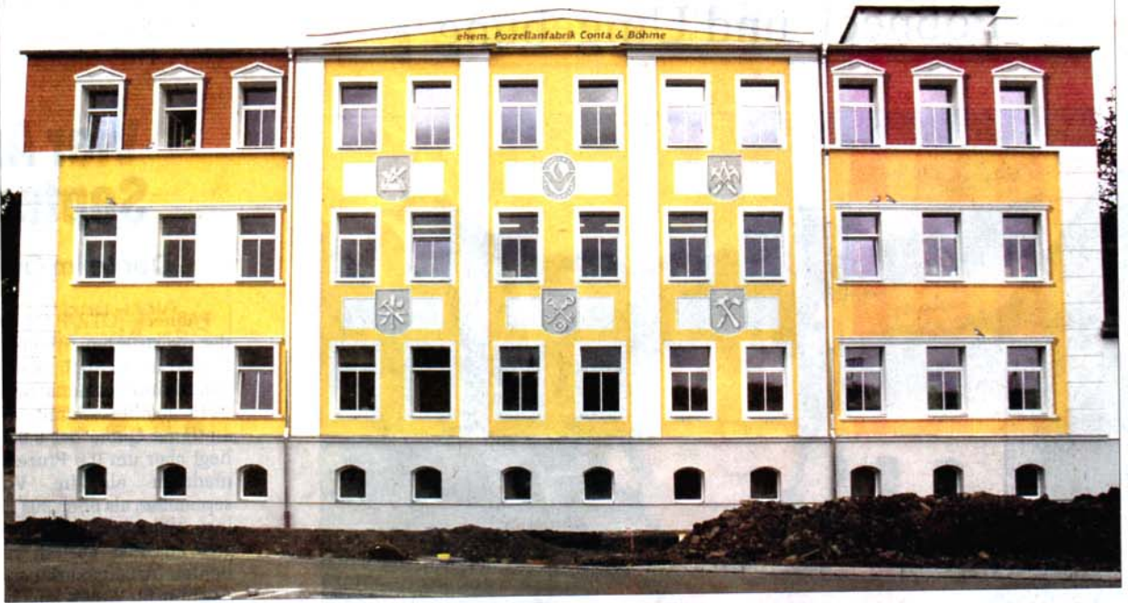
Die Saalfelder Straße 24c in Pößneck nach der Sanierung: Vor dem Gebäude, das einst zur Porzellanfabrik Conta & Böhme gehörte, wird noch an der Bundesstraße 281 gebaut. (Foto: OTZ/Marius Koity)
