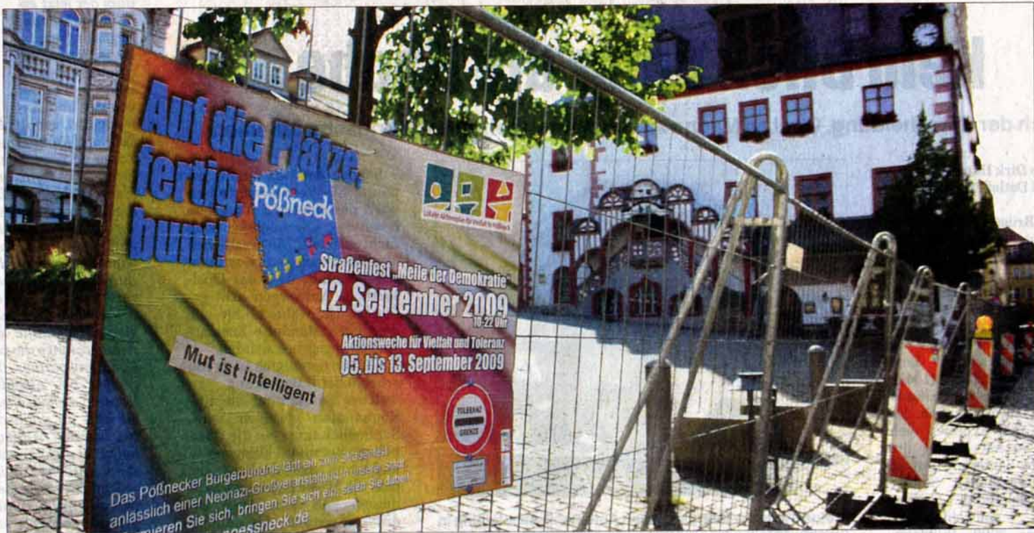
Der Pöbnecker Marktplatz wurde eingezäunt, damit sein teils loses Pflaster, das ab Montag saniert werden soll, heute nicht zweckentfremdet werden kann. Am Gitter ruft ein Plakat wie überall in der Stadt zur Beteiligung an der „Meile der Demokratie“ auf. (Foto: OTZ/Marius Koity)
