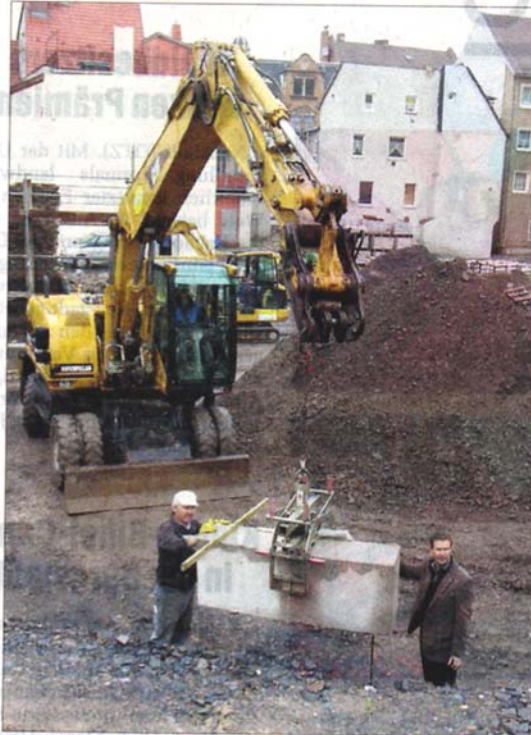
Polier Matthias Langrock (links) und Architekt Martin Raffelt bringen den ersten von 101 Granitblöcken für die Sitzstufenanlage in Position. (Foto: OTZ/Marius Koity)
