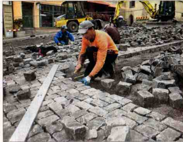
Sebastiao Celestino und seine Kollegen von der Fa. Holler + Knab aus Seubtendorf kommen mit der Neupflasterung des Pößnecker Marktes gut voran. (Foto: OTZ/Marius Koity)
