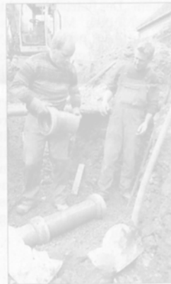
Claus Seidel und Sven Frister arbeiten an einem Kanal-Hausanschluss.
