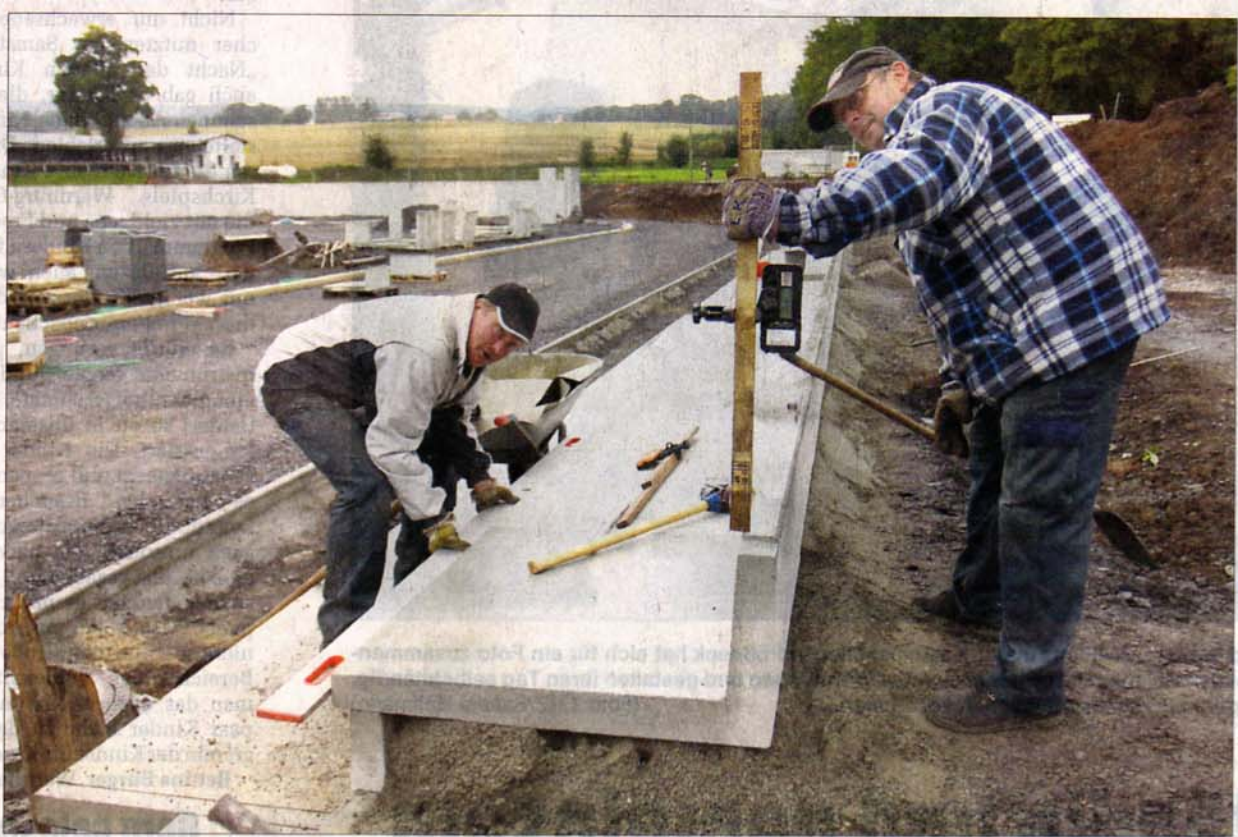
Steffen Böhme (links) und Lutz Kröber von der Firma Barthel Sportanlagen aus Großwig (Sachsen) sorgen beim Bau der Steh-Sitz-Tribüne des Griebensportplatzes in Pöbneck dafür, dass alles schön im Lot ist. (Fotos [2]: OTZ/Marius Koity)
