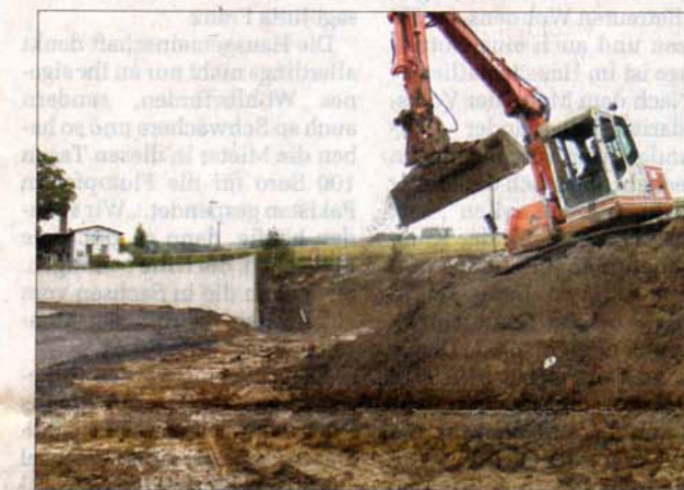
Ein Bagger macht Platz für den Auslauf der 110-Meter-Hürden-Läufer, links schließt sich die neue Stützwand an.
