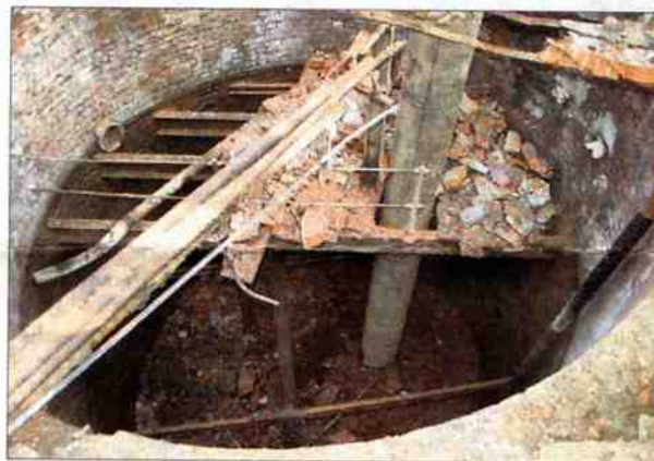
Die alte Metallkonstruktion, von der die fünf Meter breite und sechs Meter tiefe Zisterne einst im Inneren bewirtschaftet wurde, wird in den nächsten Tagen entfernt.
